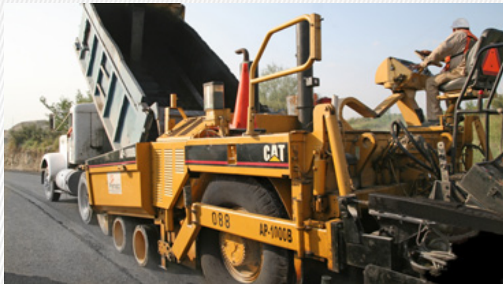
Suministro y aplicación de concreto asfáltico
