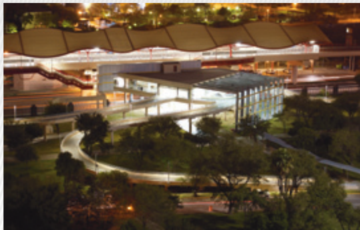
Línea II de Metrorrey - Estación Universidad (Monterrey, N.L.)
